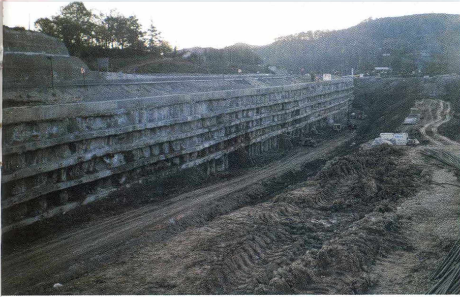
Şekil 14: E-5 Karayolunun Bolu Doğu'nda forekazık sistemiyle güçlendirilmiş kesiminden bir görünüm (Bu bölüm depremden etkilenmemiştir).
